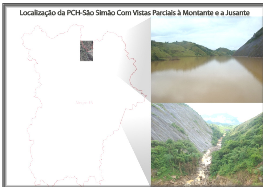
Figura 01 - Localização da Pequena Central Hidroelétrica – São Simão no município de Alegre – ES, com vistas parciais à montante e a jusante.
