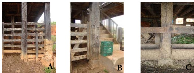
Figura 6. Peças estruturais deterioradas e intervindas. a) Melanoxylon braúna , b) Euxylophora paraenses . c) Tabebuia sp.
